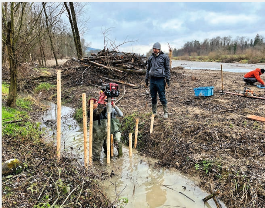
Fig. 9a Der Bau von BDA erfordert i.d.R. nur einfache Werkzeuge und Baumaterialien. Üblicherweise wird zuerst ein Grundgerüst aus Holzpfählen erstellt. Lage, Höhe, Breite und Verankerung der BDA sind auf die Projektanforderungen abzustimmen (vgl. Kap. «Planungsgrundsätze»). (©S. Minnig)
