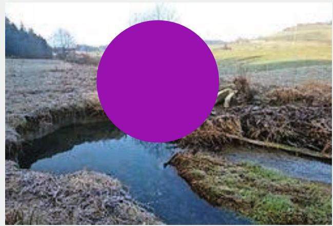
Fig. 7b Sechs Monate später: Ein Hochwasser spülte den Damm teilweise weg. Die darauffolgende Ufererosion liefert das notwendige Substrat für die Sohlenanhebung im Unterlauf. Mit BDAs können diese Uferanrisse in Lage und Ausdehnung gesteuert werden (vgl. Stadium B, Fig. 2 und Kap. «Planungsgrundsätze»). (©T. Polli)
